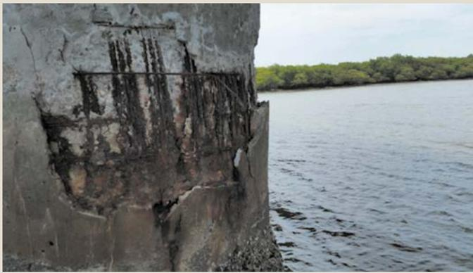
Detalhe mostrando deslocamento e corrosão acentuada. Foto do autor.
