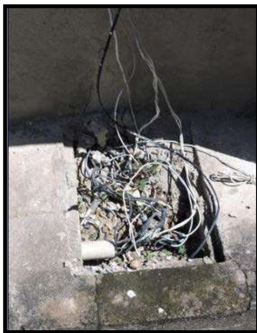
Figura 30– Fiação exposta
