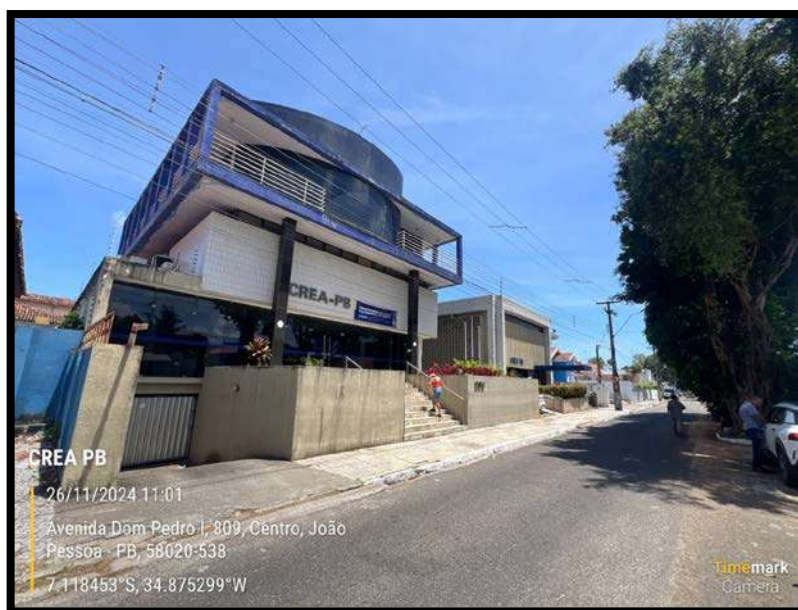
Figura 24– Fachada prédio atendimento ao público
