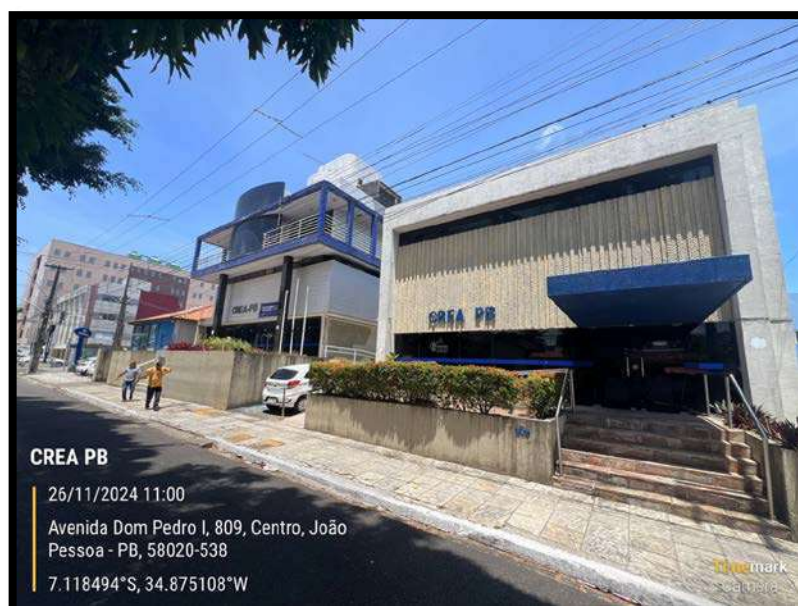
Figura 5– Fachada prédio Administrativo
