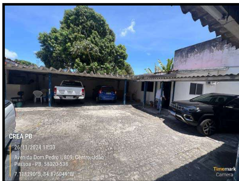
Figura 22 – Pavimentação do pátio com irregularidades
