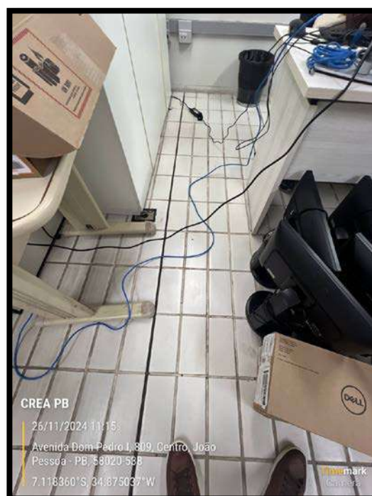
Figura 11 – Cabos expostos nas salas
