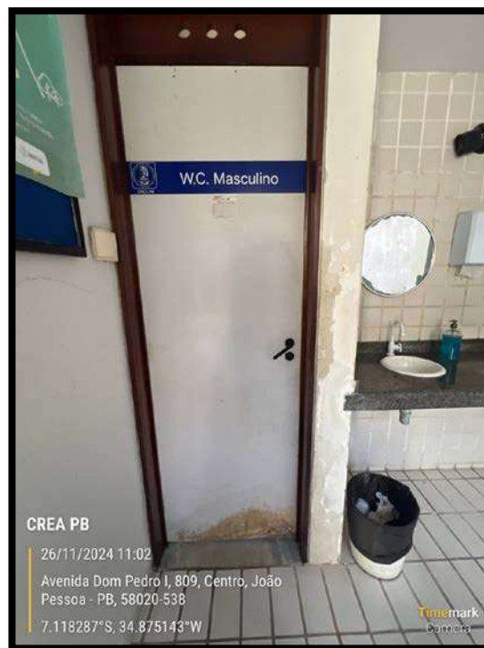
Figura 14 – Portas deterioradas
