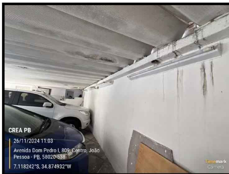
Figura 21 – Garagem com infiltrações
