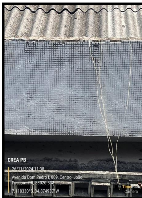
Figura 5 – Cabos expostos na fachada
