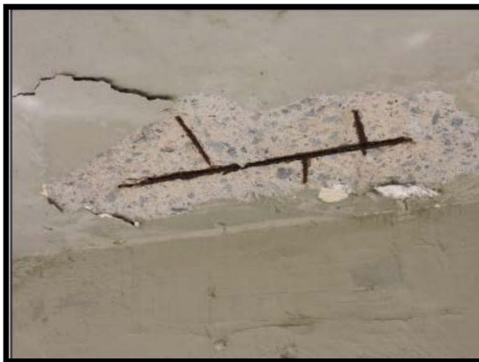
Figura 29– Ferragens expostas em estado de corrosão
