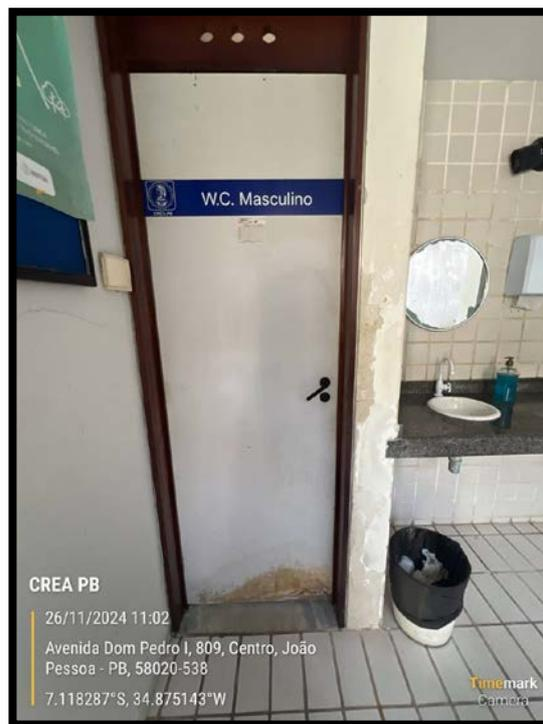
Figura 14 – Portas deterioradas
