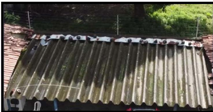
Figura 3 – Telhado Kalhetão totalmente deteriorado
