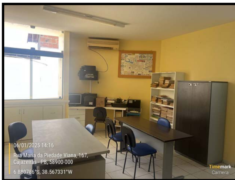
Figura 9 – Área Interna necessitando de reparos e troca de piso
