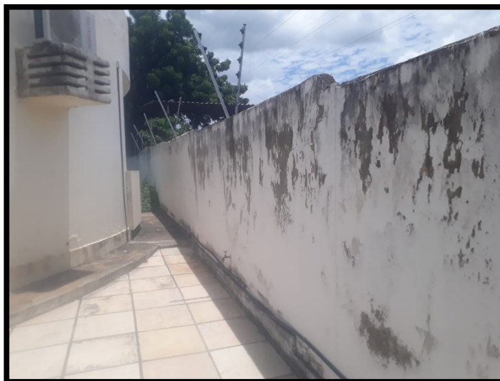
Figura 12 – Pintura do muro descascando
