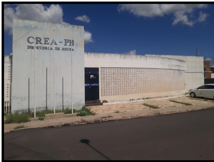
Figura 16- Identidade Visual Ultrapassada e pitnura queimada descascando
